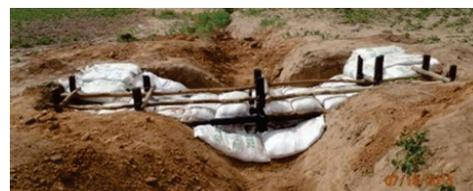
Mise en place de diguette en cadre (sacs de sable)
