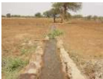
Canal plein d'eau
