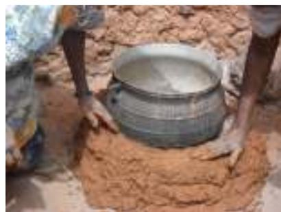
Le mur du foyer se construit et monte couche par couche en tassant bien jusqu'à la hauteur des oreilles de la marmite.
