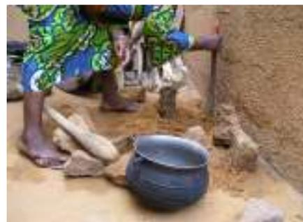
Creuser et loger les pierres. Ajuster et réajuster les pierres jusqu' à obtenir les normes requises.
