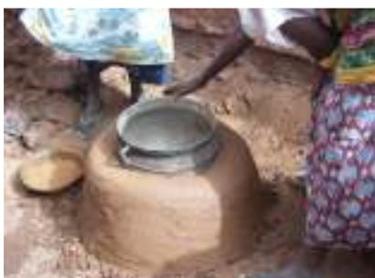
Uniformiser l'épaisseur du mur du foyer (épaisseur de 4 doigts soit 8 cm environ); Nivelier la face extérieure du foyer avec la main mouillée.
