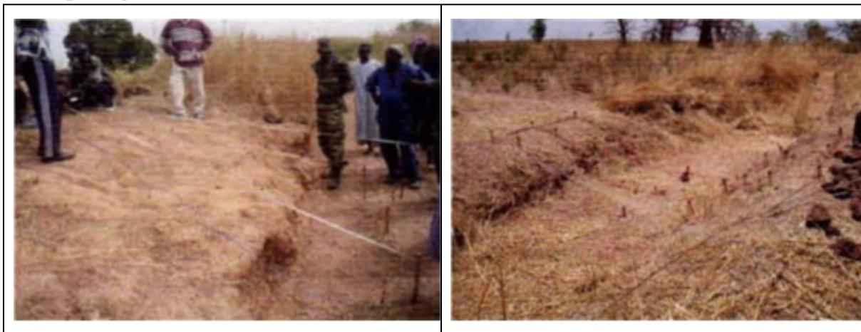
**(6) Travaux de creusement des fondations pour l'installation de la diguette en cadre**
